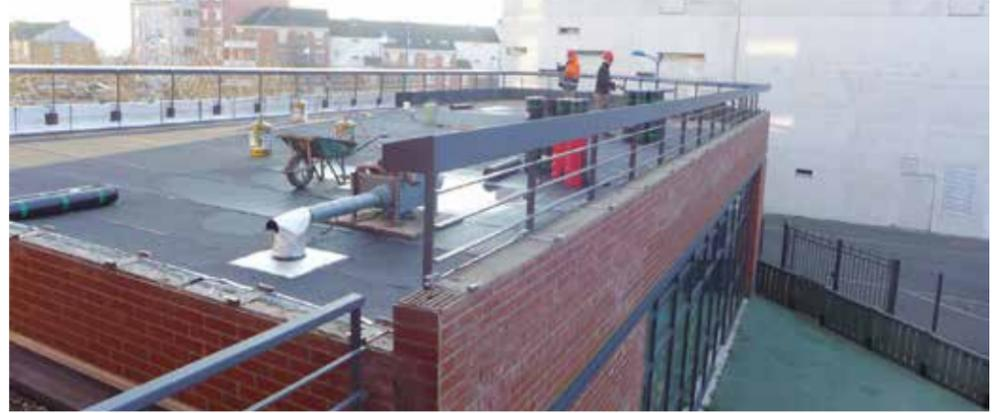
les tests fumigènes réalisés, la décision a été prise de faire évoluer cette réparation pour la mise au sec de nos chers chérubins par une réfection complète de la toiture. Ces gros travaux d'étanchéité terminés, la structure a pu retrouver son fonctionnement normal, nos P'tits Bouts à même de rechanter
