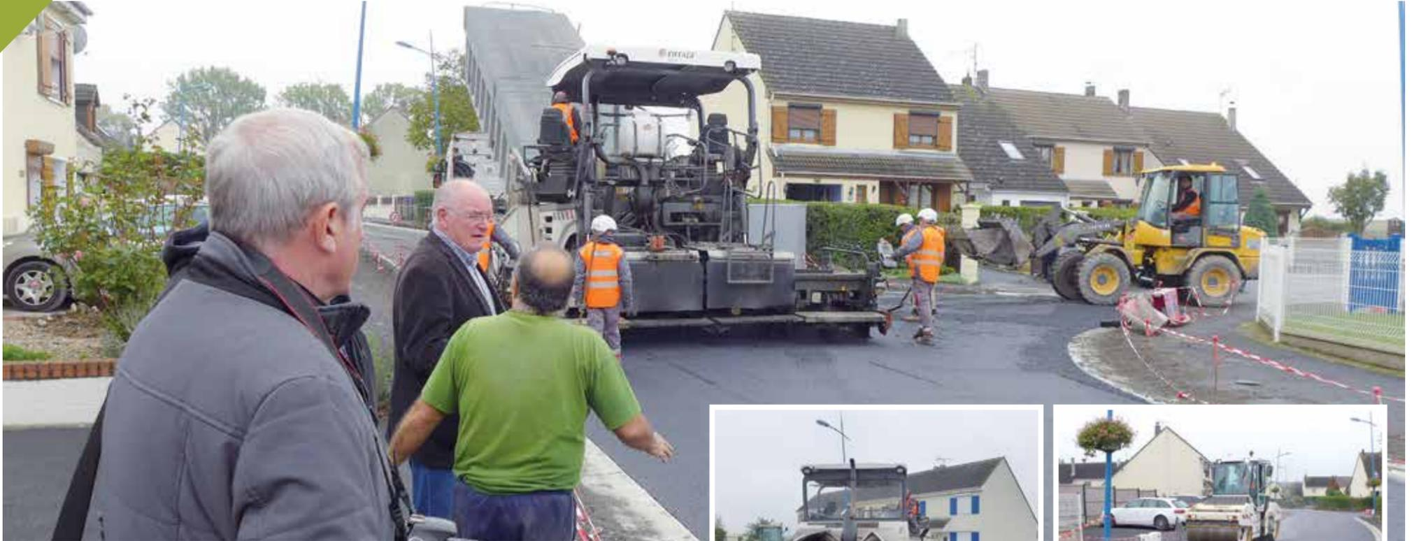
Les gros travaux de requalification de voirie du grand axe de la rue Allende se poursuivent et vont bon train - la phase de pose d'enrobé a fait suite à celle de l'ouverture de chaussée utile à l'accueil du nouveau câble d'alimentation électrique - aménagement des trottoirs et signalisation termineront ces importants travaux...
