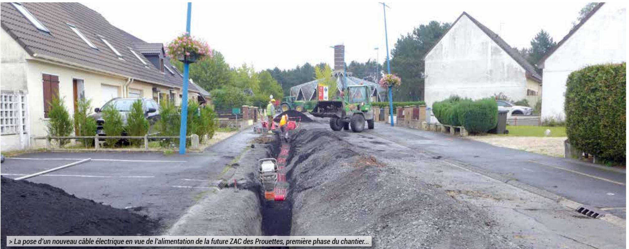
> La pose d'un nouveau câble électrique en vue de l'alimentation de la future ZAC des Prouettes, première phase du chantier...
