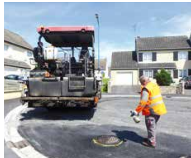
> La réfection des raquettes, 1 ère phase de ces travaux.
